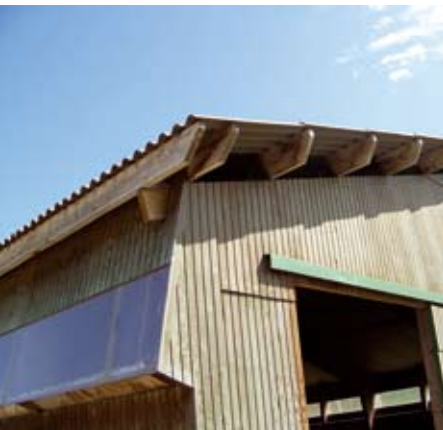
La bergerie est modifiée pour adapter sa structure au séchage solaire
